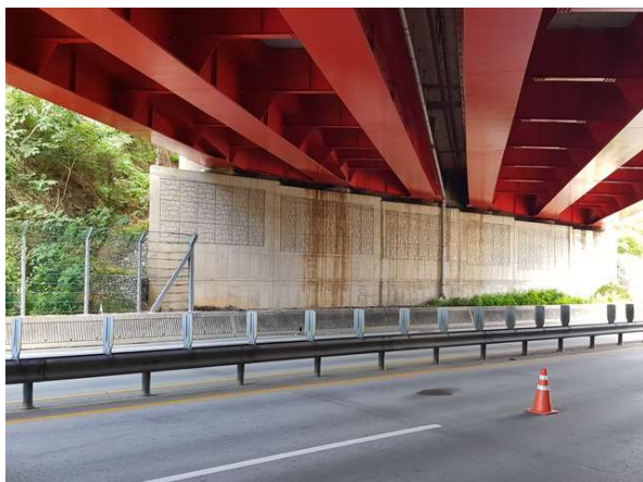
교대 A1 전경
