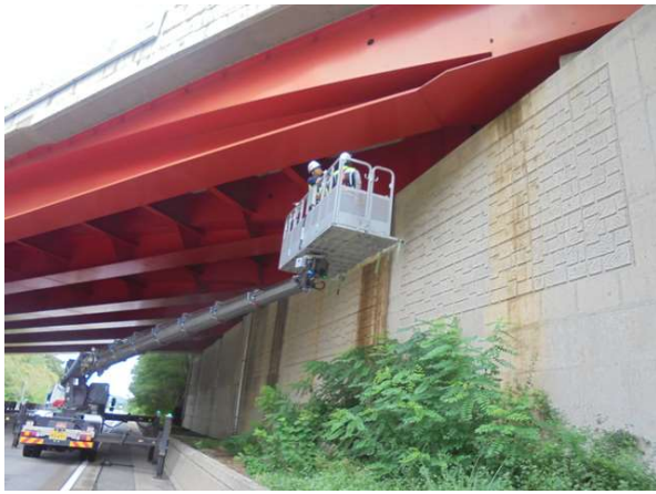
고소작업차를 이용한 부재치수 현장측정
