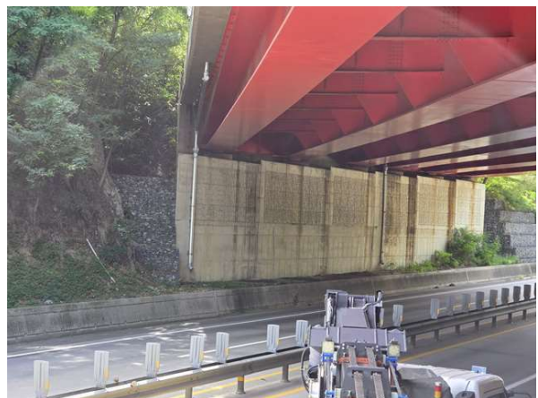
교대 A2 전경
